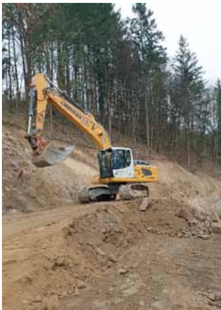
Bauarbeiten durch Fa. Arthofer
